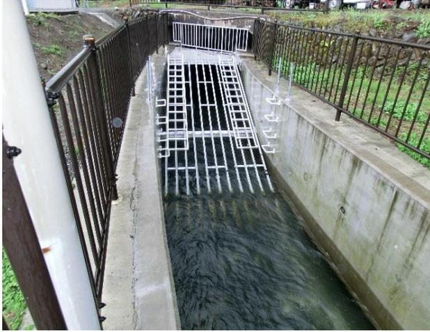
・固定式 角度20° 目幅150mm 昇降梯子、専用レーキ付
