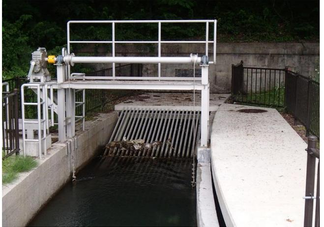
・昇降装置付跳上式 角度23° 目幅50mm
